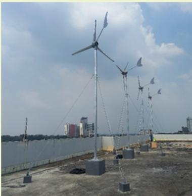
Proyek Pemasangan **Pembangkit Listrik Tenaga Banyu (PLTB)** yang berlokasi di Pusgiwa Universitas Indonesia, Depok ini mempunyai kapasitas 4 kWp. Energi yang didapatkan dari PLTB ini digunakan untuk menerangi lampu-lampu taman di Gedung Pusgiwa UI yang berjumlah 25 unit lampu taman dan dua unit lampu sorot LED.
